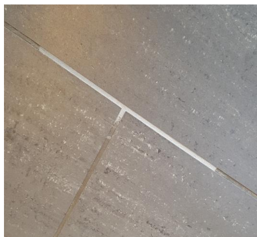
Før/etter bruk av Fug Rens
